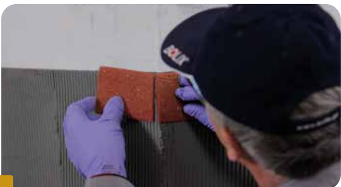
Fot.4 Przyklejanie przyciętych płytek w narożu.
