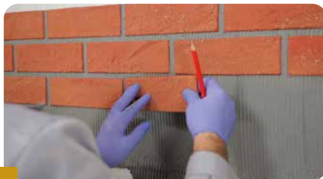
Fot.7 Przyklejanie płytek elastycznych od góry do dołu.
