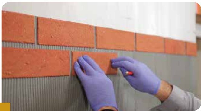
Fot.8 Dociskanie płytek elastycznych
