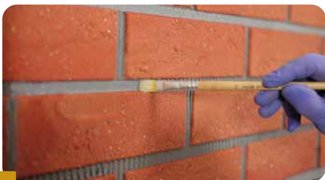
Fot.10. Zasklepianie i formowanie spoiny przy użyciu płaskiego, wilgotnego pędzelka o szerokości spoiny.
