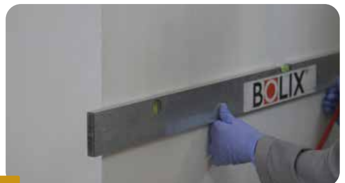
Fot.1 Oznaczenie linii rozmieszczenia płytek elastycznych
