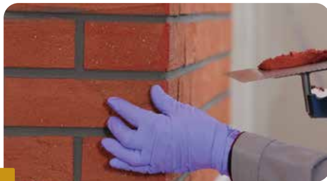
Fot.5 Wypełnienie szczeliny masą BOLIX BQS MASS
