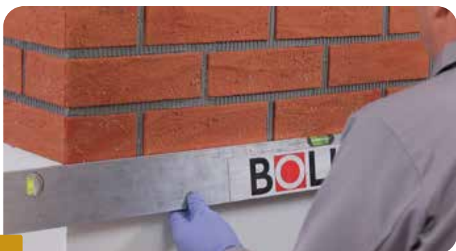
Fot. 9 Weryfikacja liniowego przebiegu spoiny poziomej przy użyciu poziomicy
