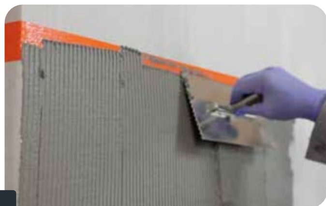
Fot. 2 - Rozprowadzanie masy klejąco-spojującej BOLIX BOB
