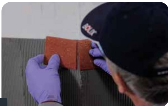
Fot. 4 - Przyklejanie przyciętych płytek w narożu.
