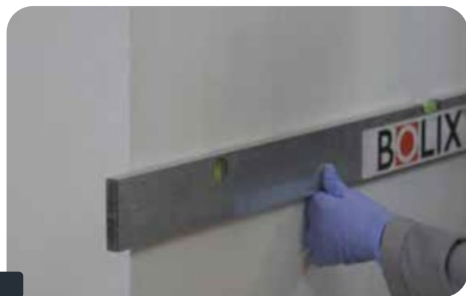
Fot. 1 - Oznaczenie linii rozmieszczenia płytek elastycznych
