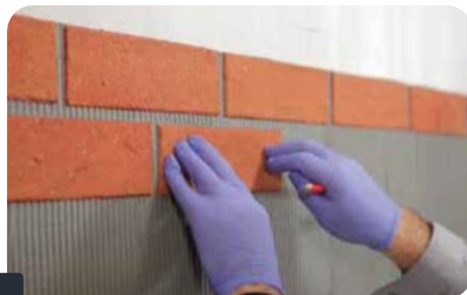
Fot. 7 - Dociskanie płytek elastycznych
