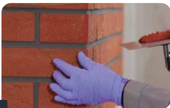
Fot. 5 - Wypełnienie szczeliny masą BOLIX BQS MASS
