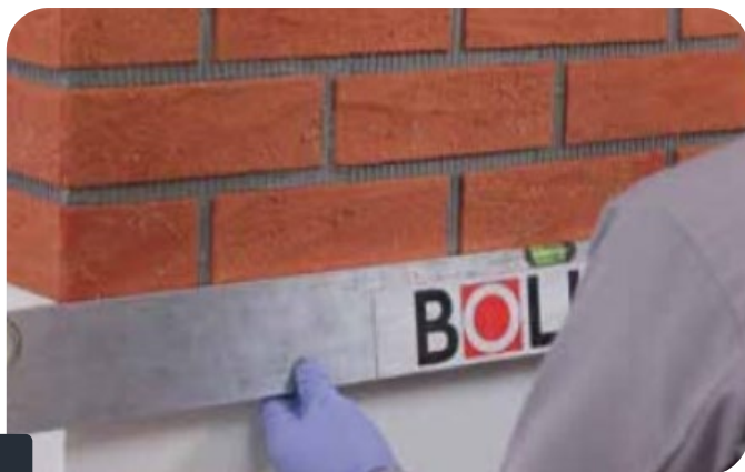
Fot. 8 - Weryfikacja liniowego przebiegu spoiny poziomej przy użyciu poziomicy
