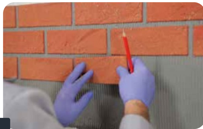
Fot. 6 - Przyklejanie płytek elastycznych od góry do dołu
