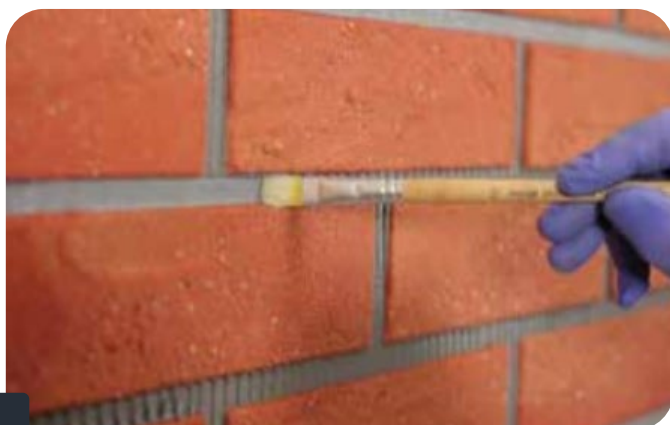
Fot. 9 - Zasklepienie i formowanie spoiny przy użyciu płaskiego, wilgotnego pędzla o szerokości spoiny
